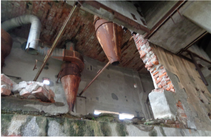
Figura 10 Componenti metalliche da dividere dagli inerti durante la demolizione dei fabbricati
