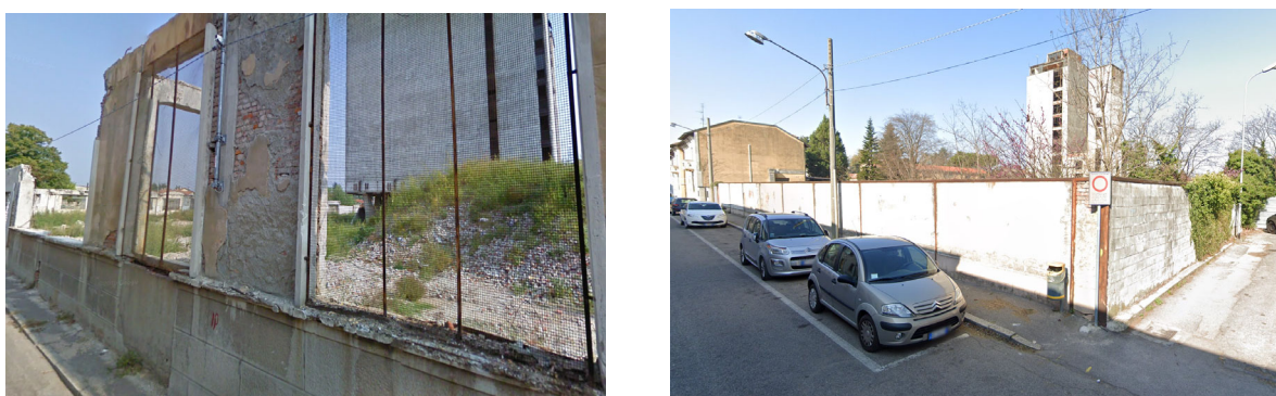
Figura 7 Muri di confine dell'area da demolire
