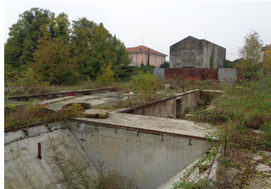
Figura 3 Vasche interrate e tramogge fuori terra
