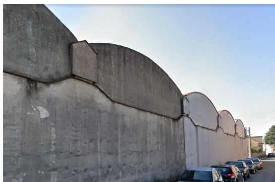
Figura 5 Setti in c.a. frontespicienti Via Fratelli Bandiera
