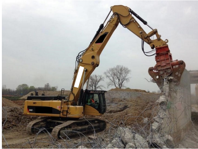
Figura 12 Escavatore a braccio lungo con pinza demolitrice-selezionatrice
