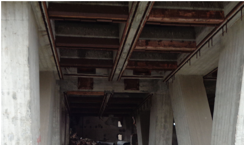
Figura 11 Travi metalliche presenti nell'edificio da demolire
