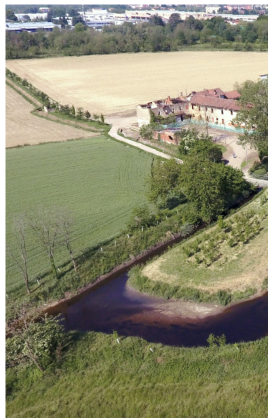
lavori di riqualificazione ambientale presso il Molino Prepositurale
