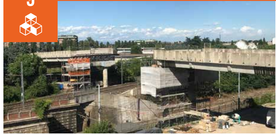
Lavori per la messa in sicurezza del cavalcavia Buonarroti, nell'ambito del Piano Sistemático di Sorveglianza ed Ispezione, adottato dal Comune per il controllo pianificato dei ponti
