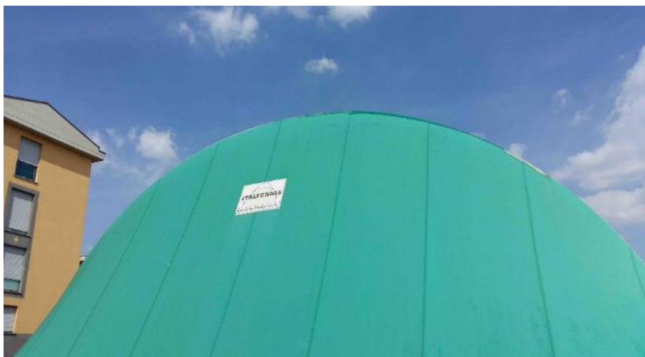
Figura 7: Campi da tennis vista frontale copertura
