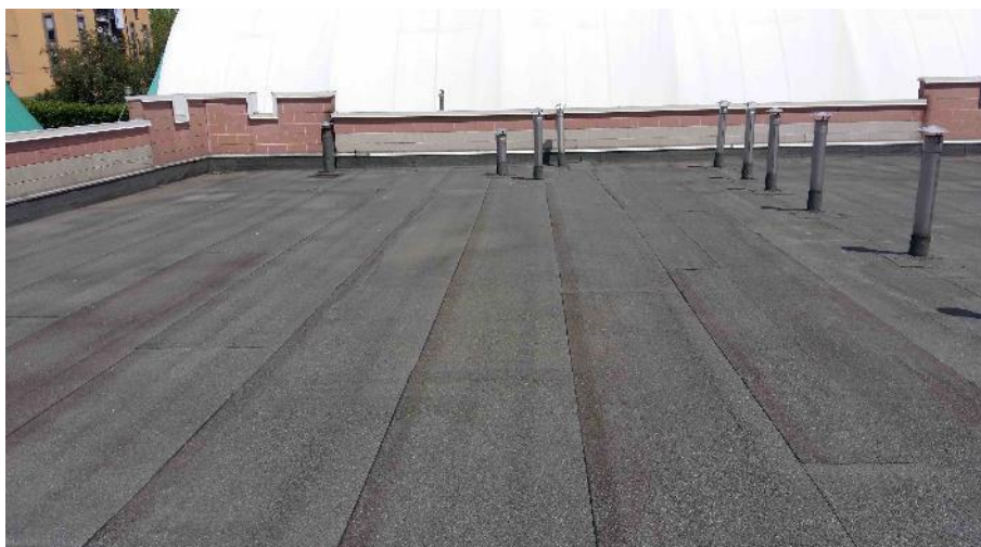
Figura 5: Fabbricato Bar vista generale della copertura in guaina bituminosa
