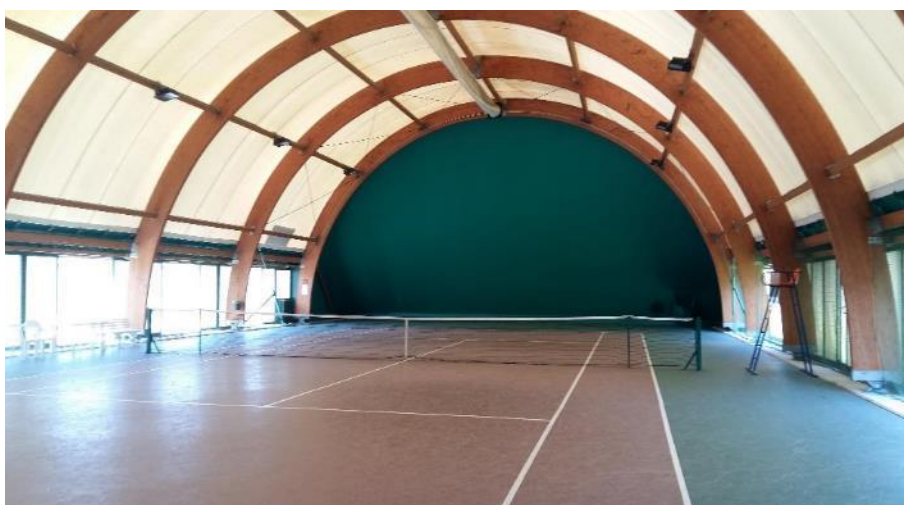
Figura 7: Campi da tennis vista campo interno
