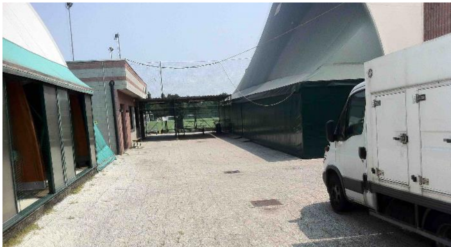
Figura 3: pavimentazioni esterne e fabbricato cucina
