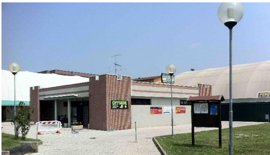
Figura 4: Fabbricato bar vista d'insieme
