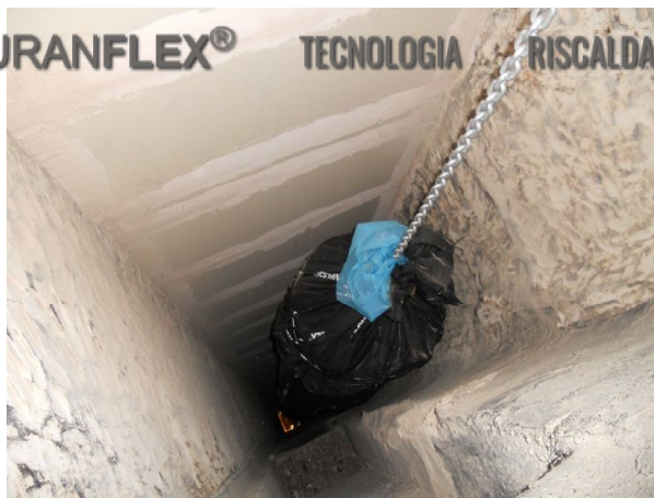
Introduzione di FuranFlex® con l'ausilio d'un argano
