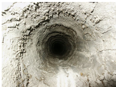
Foto di un camino da rivestire con FuranFlex® prima e dopo la preparazione
