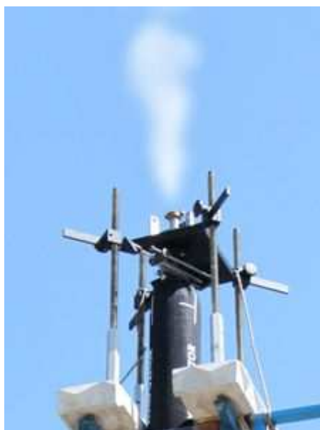
Il vapore utilizzato durante l'indurimento del FuranFlex® si allontana attraverso la valvola superiore
