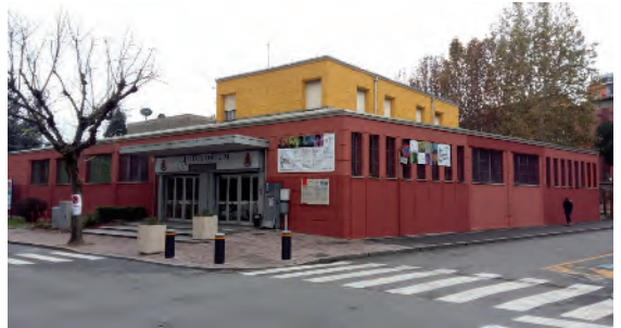
Facciata colorata e interventi di arredo urbano eseguiti all'esterno dell'Auditorium
