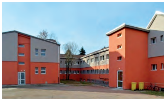
Scuola Bonecchi dopo i lavori
