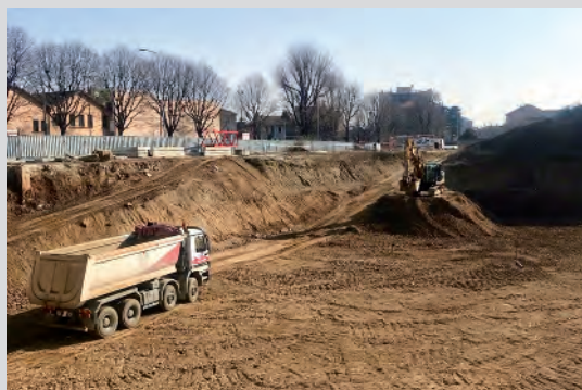
Il cantiere del nuovo teatro
