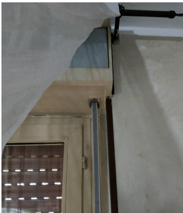
Serramento in legno e cassonetto da sostituire
