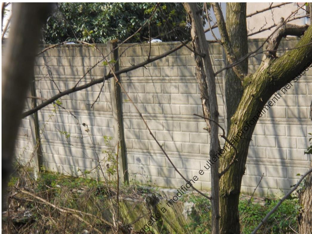
**Figura 8. Muro di recinzione pericolante in frodo al torrente in località Biringhella.**
