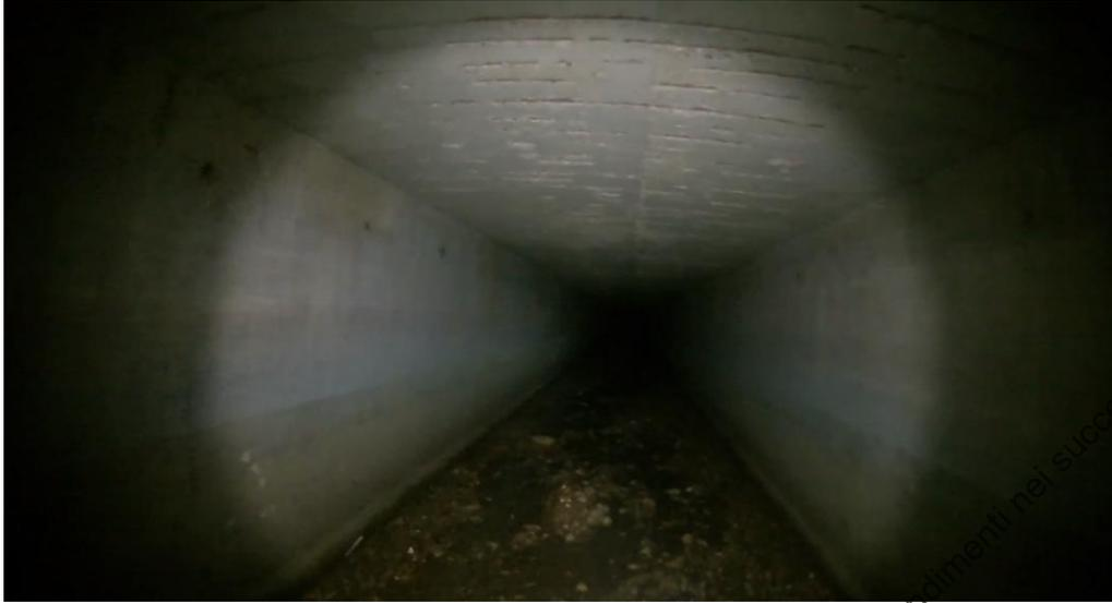
**Figura 19 - interno dello scolmatore del Bozzente - degrado della soletta in calcestruzzo**
