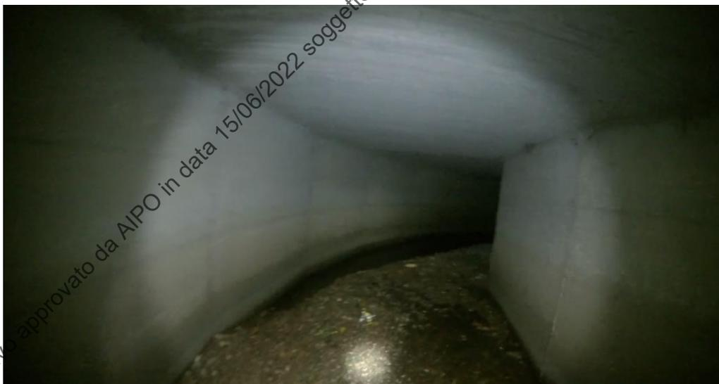
**Figura 18 - interno dello scolmatore del Bozzente - buono stato di conservazione**
