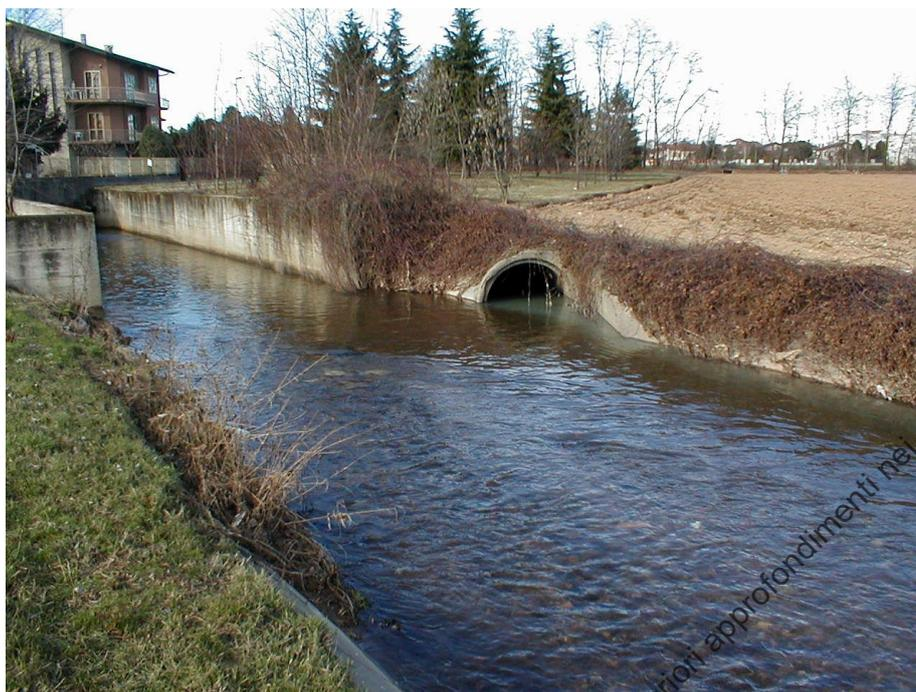
**Figura 4. Scarico in Bozzente del sistema di drenaggio di Lainate.**
